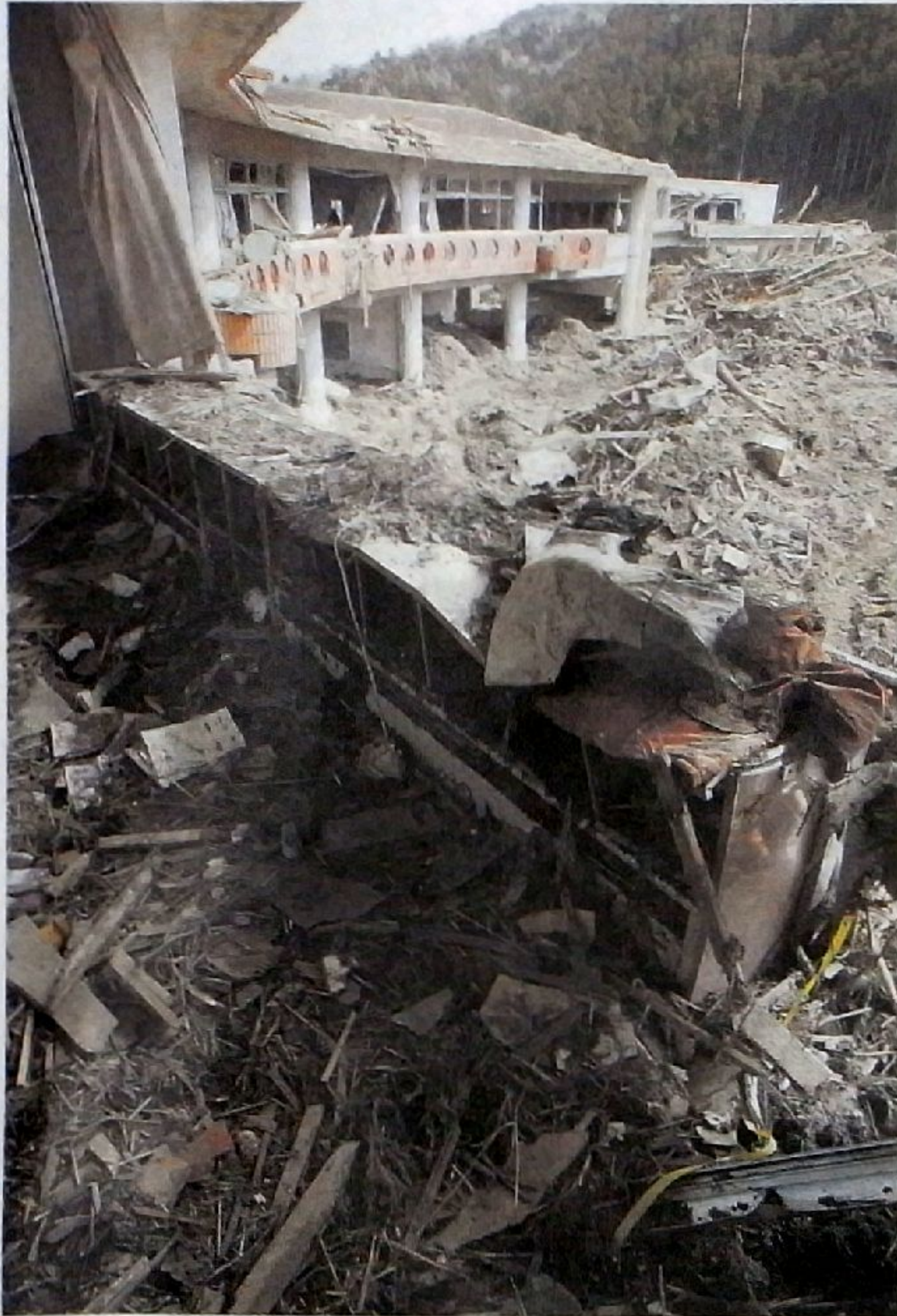
大川小の校舎。2階まで壁が抜け、屋根には津波に運ばれたがれきや建材が打ち寄せた
